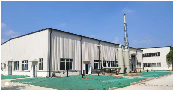
污水处理站排气筒（9#）
