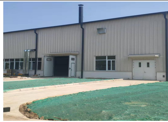
热水锅炉排气筒（5#）
