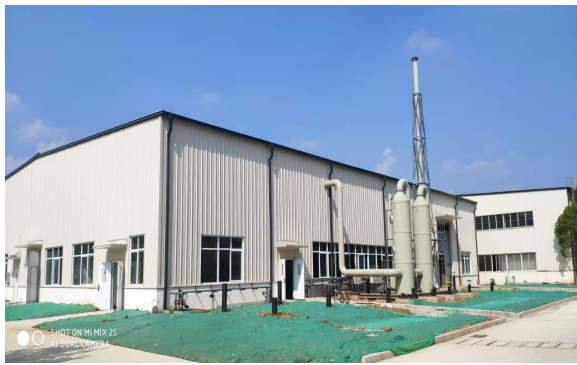
污水处理站排气筒
